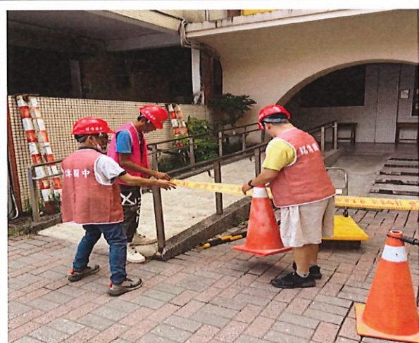
安全防護組巡視校園後拉封鎖線
