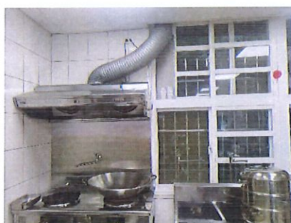
廚房抽油煙機、靜電 油煙處理設施設備
